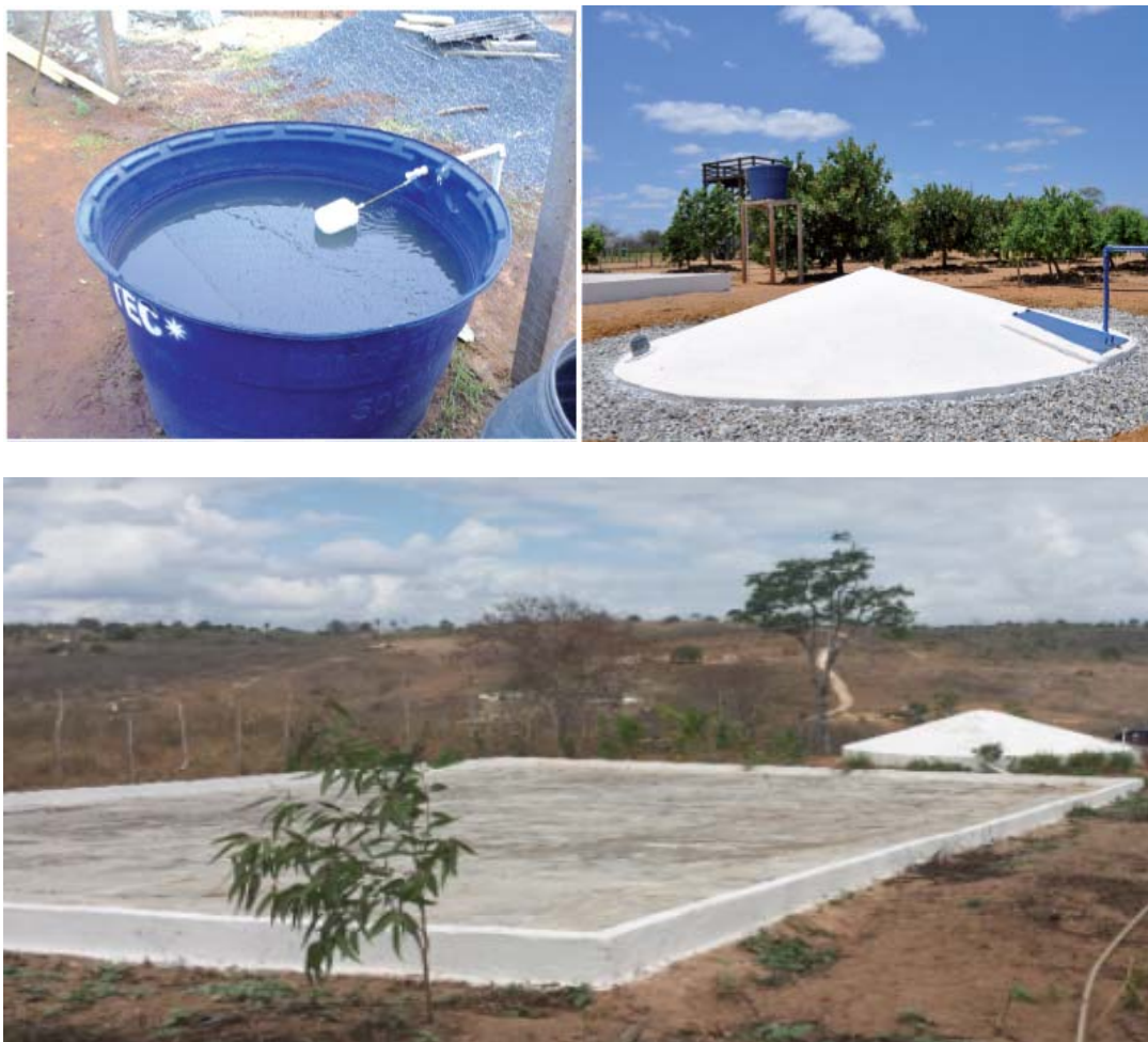
Figura 7.8: Modelos de Caixas d'Água e Cisternas que Podem Ser Utilizadas no Armazenamento de Água para Uso na Irrigação das Hortas.
