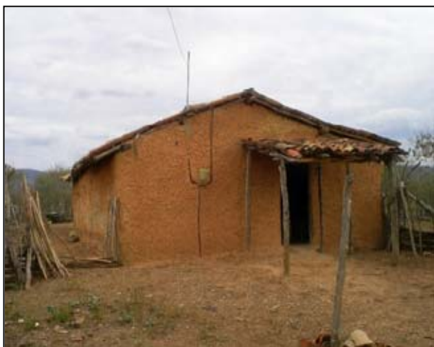
Foto 11 – Habitação de taipa na área da bacia hidráulica do futuro reservatório (E-300.897; N-9.577.488).
