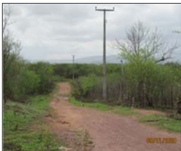
Foto 16 – Via de acesso as localidades de Caiçara I, Caiçara II e Vazante e rede de energia elétrica que atende estas localidades. (E-301491.106; N-9582540.029)
