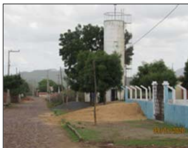
Foto 20 – Via de acesso e sistema de distribuição d’água que atende a localidade de Pau Branco.
