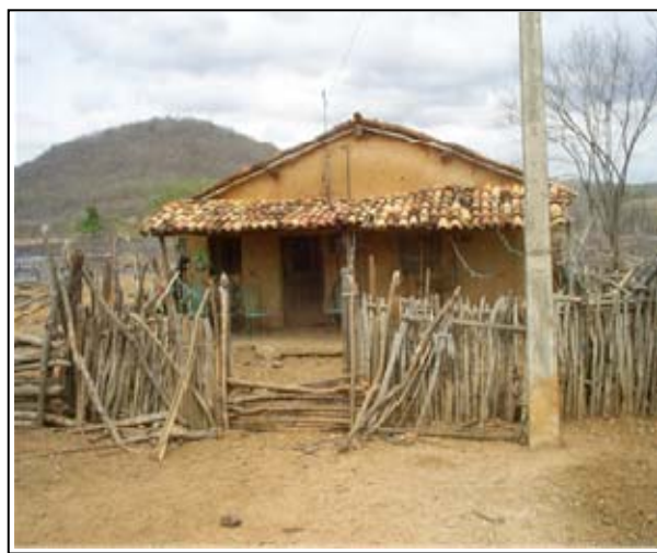
Foto 12 - Rede elétrica de baixa tensão que atende os imóveis da área da bacia hidráulica do futuro reservatório (E-303.021; N-9.579.283).
